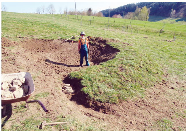
Tůňka s hrází a přepadem na jarní vody v linii soustředěného odtoku povrchové vody. Suchý Důl, CHKO Broumovsko.
