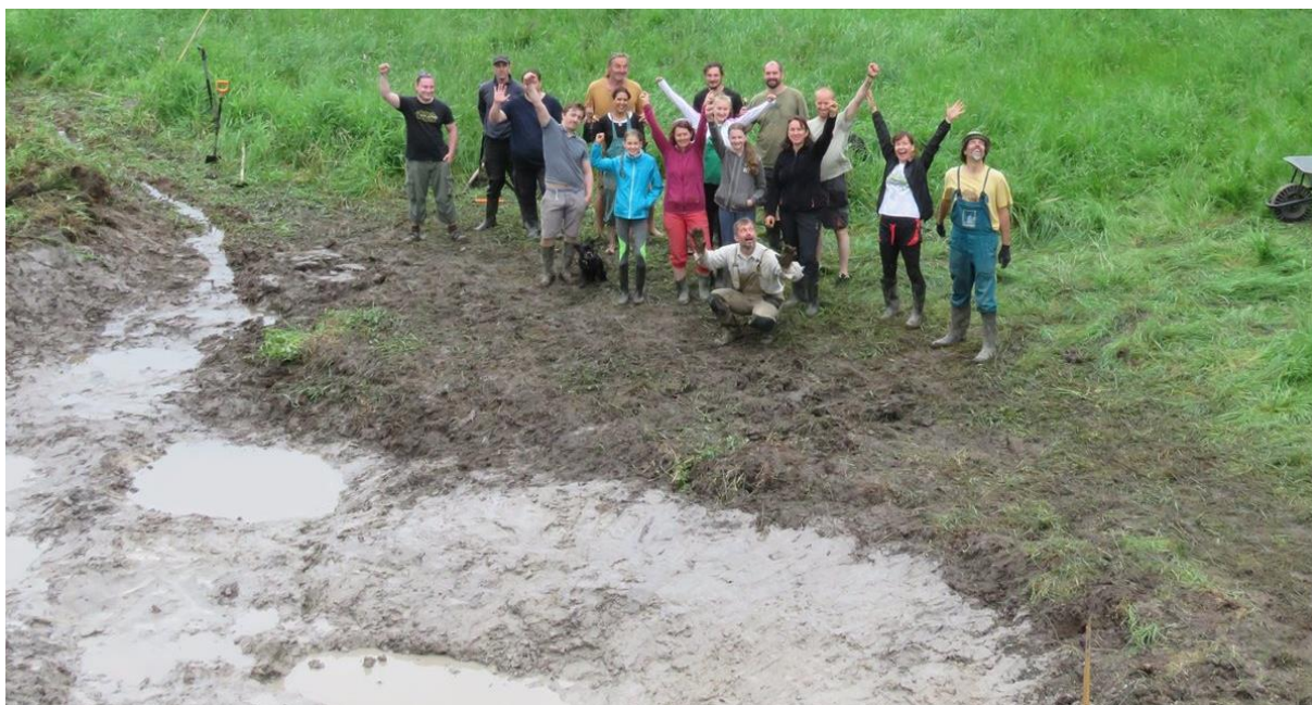
7 Naše parta s částí členů spolku Jůlinka a dobrovolníků. Vpravo sponzor akce – vlastník minibagru a dumperu, bez kterého by to šlo těžko. Foto není pořízeno dronem ale z vysokého smrku. Excentrický minipolder Wave, Libná
